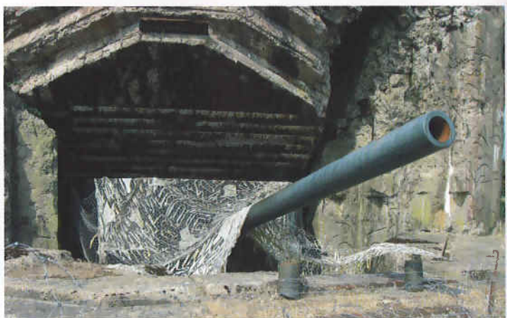
En av de stora kanonerna vid "Batterie de Crisbecq" som tillhörde Atlantvallen.
